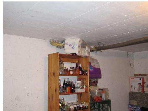
Immagine 6 Soffitto della cantina, locale ripostiglio
