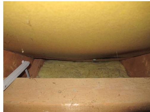
Immagine 5 Isolamento sottotetto
