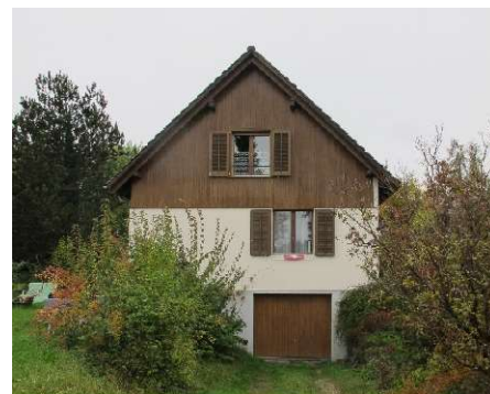
Immagine 2 Facciata est
