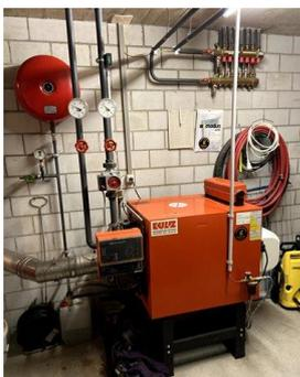
Riscaldamento a gasolio con serpentine a pavimento. Al piano interrato con termosifoni e valvole termostatiche. L'intero sistema di riscaldamento (caldaia, tubazioni, regolazione) supererà la sua vita utile nei prossimi anni.
